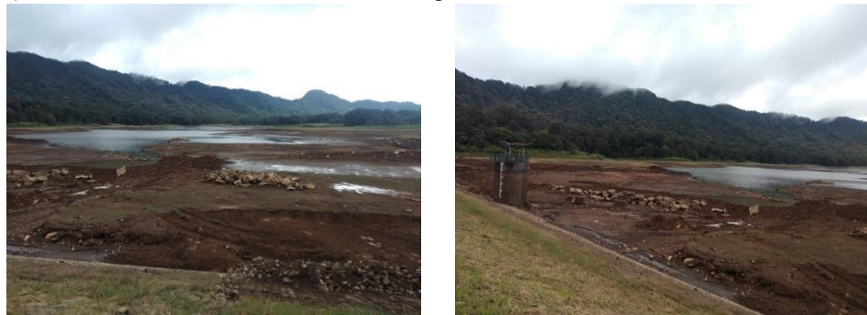
Gambar 17 Kondisi Intake Cijanggal
